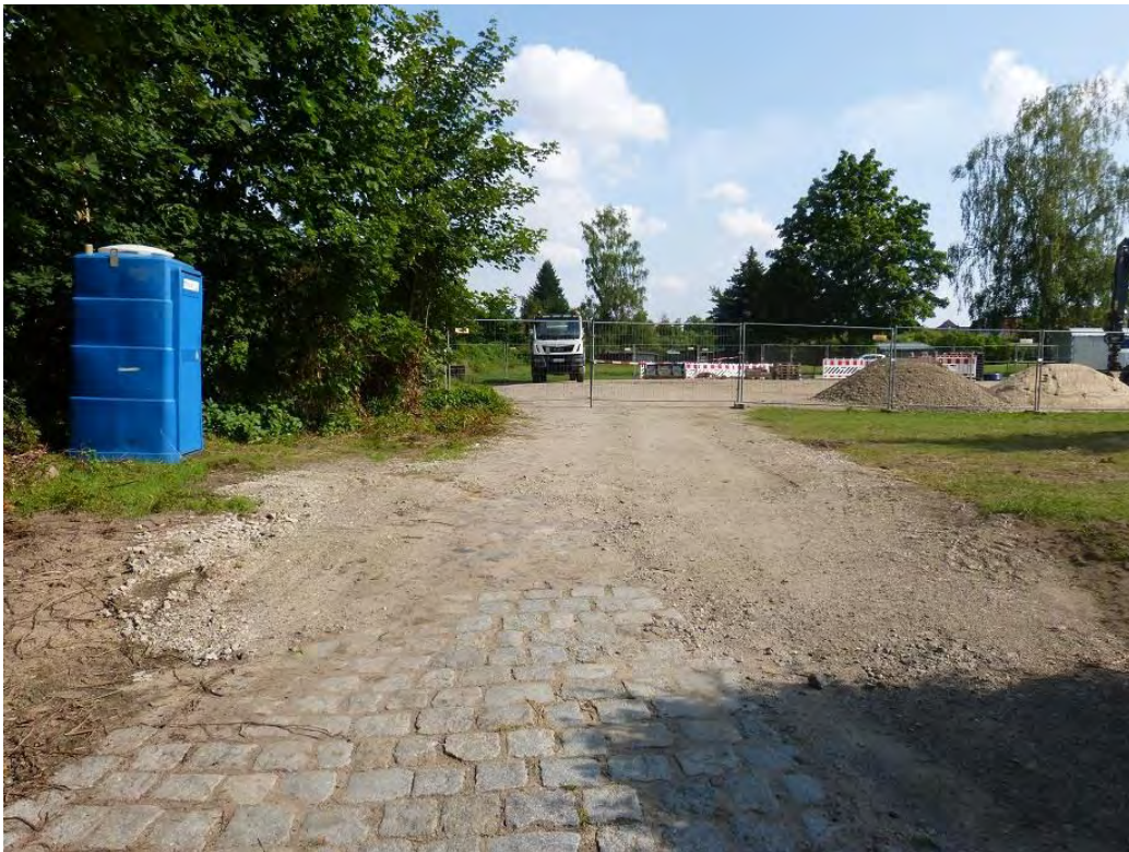
Bild 13: Geschotterte Zuwegung zur Baustelleneinrichtungs- und Lagerfläche
