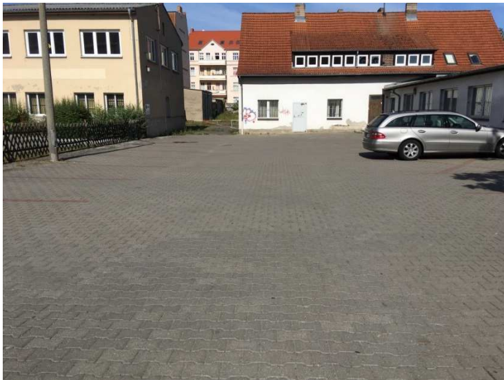
Abbildung 13: Parkplatz an der Kietzstraße (Foto_07)
