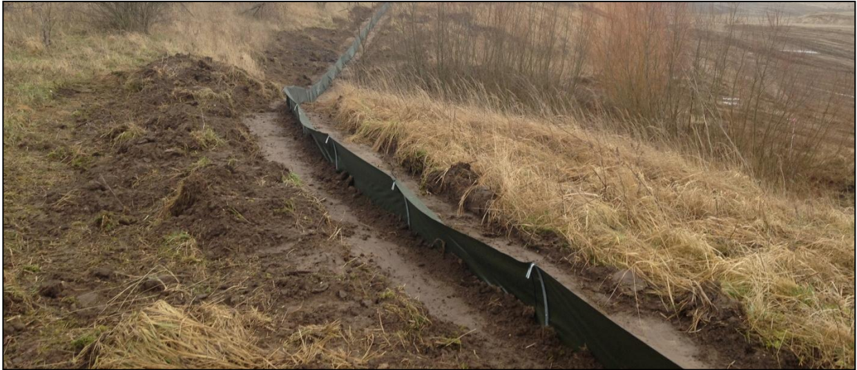
Abbildung 2: geplanter Folienschutzzaun zur Abgrenzung des Baufeldes
